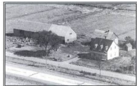
Maison et ferme familiales de Joseph Aubry situées au 182, rang des Cèdres aujourd'hui. Le rang des Plaines n'apparaît pas sur la photo en bas complètement, au centre la route 9 à une seule voie et au sud, le rang des cèdres appelé le p'tit 14.
